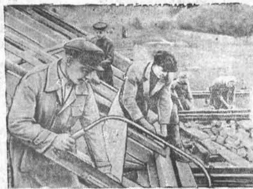
В г. Алейске идет строительство кинотеатра, которое будет закончено в этом году. НА СНИМКЕ: бригада плотников И. Л. ТАРАСОВА кроет крышу здания.
