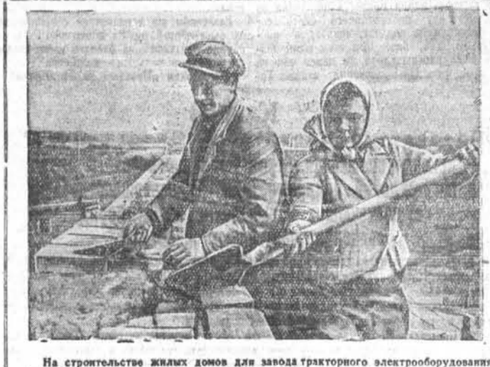
На строительстве жилых домов для завода тракторного электроборудования (г.м. Рубцовск). На первом строительном участке треста «Алтаймашстрой» отлично работает каменщик Ф. Н. Споторенко с подсобной рабочей А. П. Сиписевой. Включившись в павловское социалистическое соревнование, они ежедневно дают полторы нормы. НА СНИМКЕ: Ф. Н. СПОТОРЕНКО и А. П. СИПИСЕВА за работой. Фото Н. Калинин.
