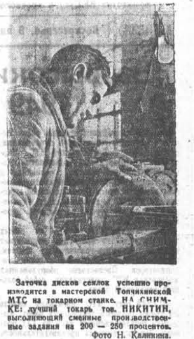
Заточка дисков сеялок успешно производится в мастерской Топчихинской МТС на токарном станке. На снимке: лучший токарь тов. НИКИТИН, выполняющий смежные производственные задания на 200 — 250 процентов. Фото Н. Калинин.
