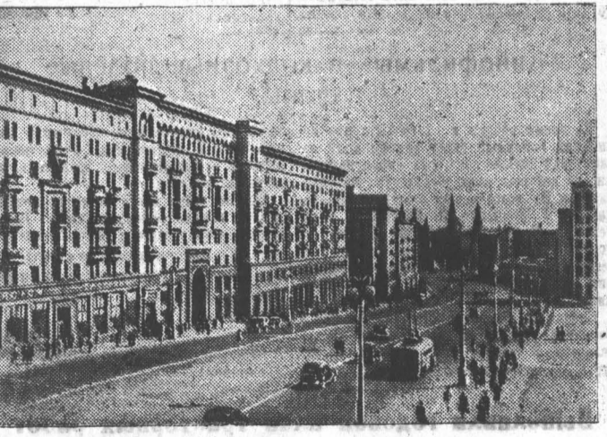
Москва. Улица Горького. Участок между Советской площадью и Опоятым районом. По левой стороне видны новые многоквартирные дома, построенные в 1930-х годах по проекту архитектора А. Г. Мордвинова, причем улица по этой стороне была расширена почти вдвое путем сноса старых домов и передвигания одного из них внутрь двора. Бышний здесь крутой склон срезан, улица засафальтирована, освещена мощными электрическими фонарями. Улица названа в честь А. М. Горького в 1935 году. Фото З. Неперовой. (Фотохроника ТАСС).
