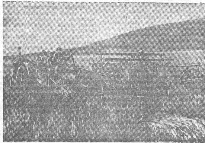
По инициативе председателя колхоза имени Чапаева, Сростинского района, Г. И. Симахина для уборки зерновых приспособлен хедер комбайна «Коммунар». НА СНИМКЕ: косовица ржи вилдрю узором.
