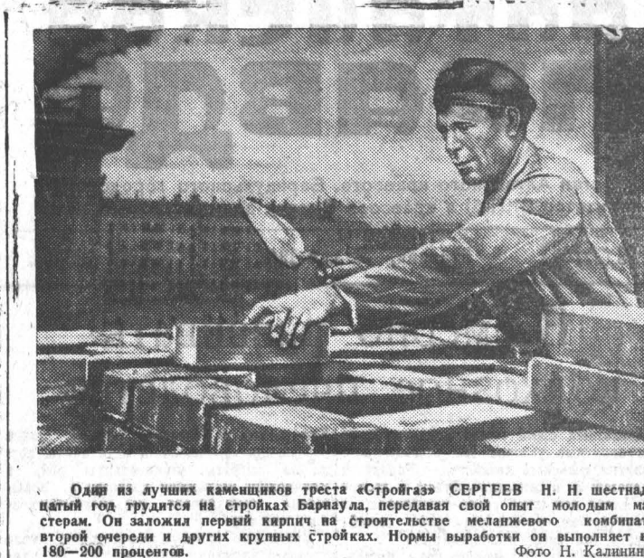
Один из лучших каменщиков треста «Стройгос» СЕРГЕЕВ Н. Н. шестнадцатый год трудится на стройках Барнаула, передавая свой опыт молодым мастерам. Он заложил первый кирпич на строительстве металлургического комбината второй очереди и других крупных стройках. Нормы выработки он выполняет на 180—200 процентов. Фото Н. Калинин.
