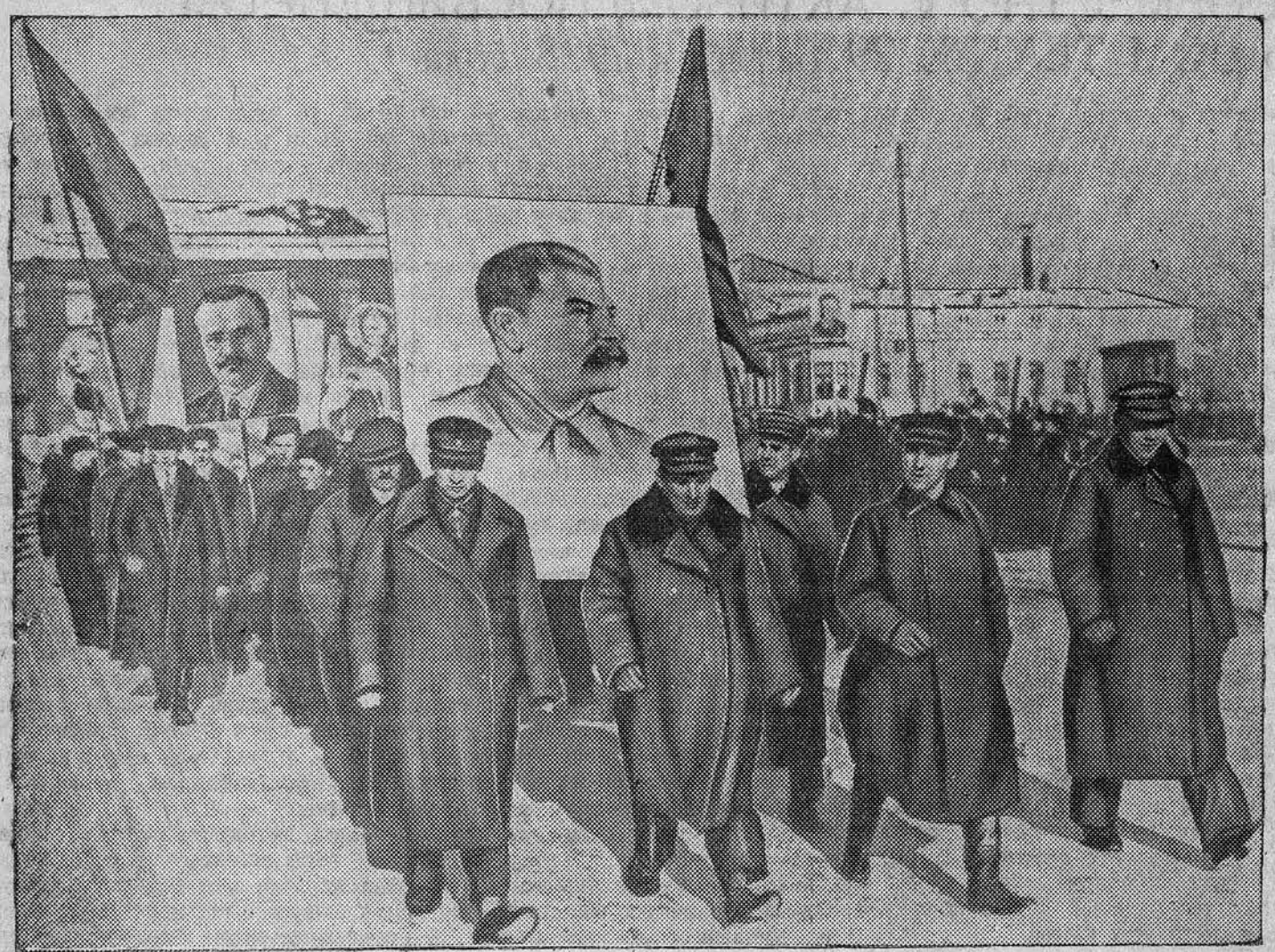
Слева колонна рабочих вагономремонтного завода. Справа знаменосцы Октябрьского района.
