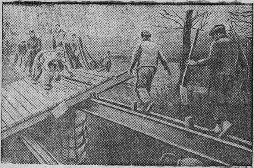
На фронтах в Испании. На снимке: бойцы республиканской армии извлекают взорванный фашистами мост.
