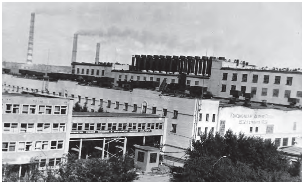
Строительство Барнаульского комбината «Химволокно». 1959 г. ГААК. Фотодокументы. Оп. 1. Д. 4813.
