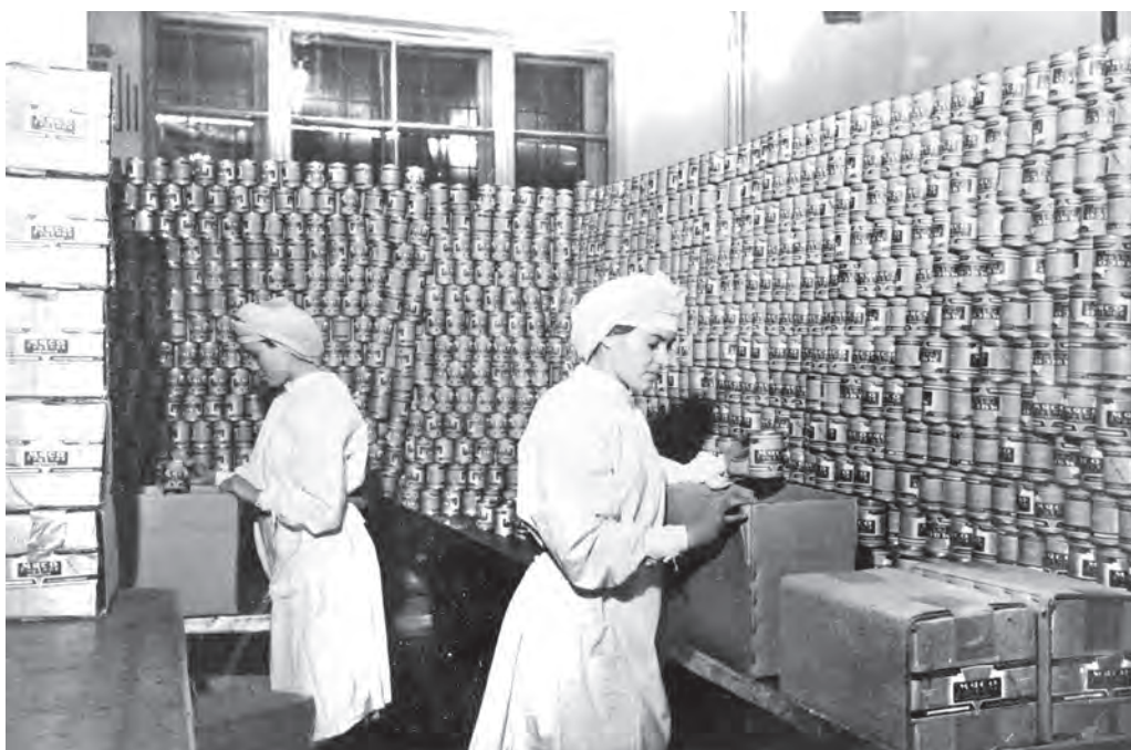
Упаковка готовой продукции на мясоконсервном заводе Бийского мясоконсервного комбината. 14 декабря 1955 г. ГААК. Фотодокументы. Оп. 2а. Д. 1-753.
