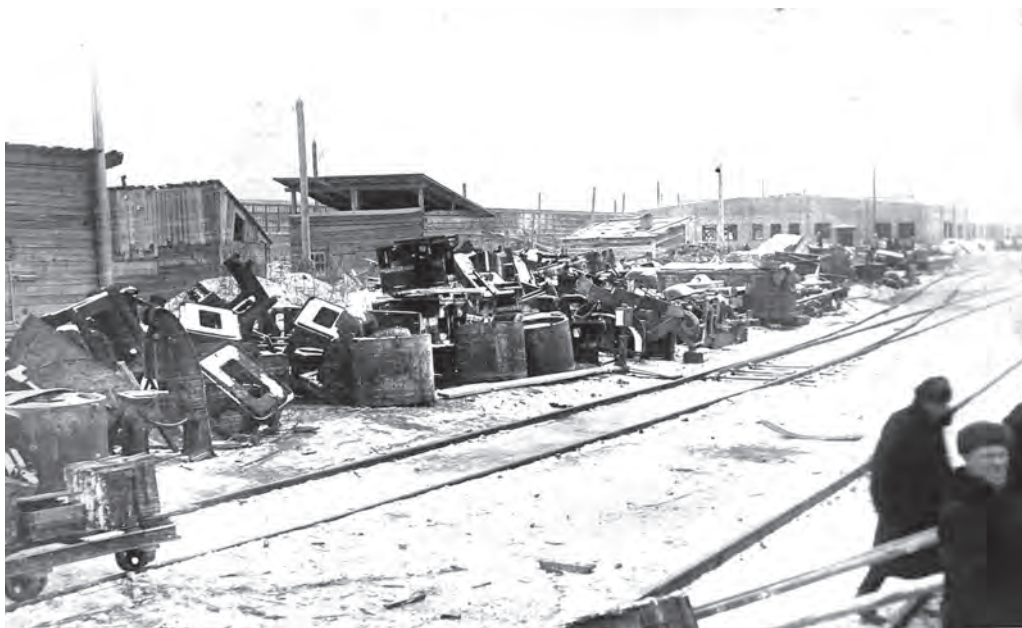
Строительство Барнаульского станкостроительного завода. 1941 г. ГААК. Ф.Р-1453. Оп. 1. Д. 18. Л. 17.
