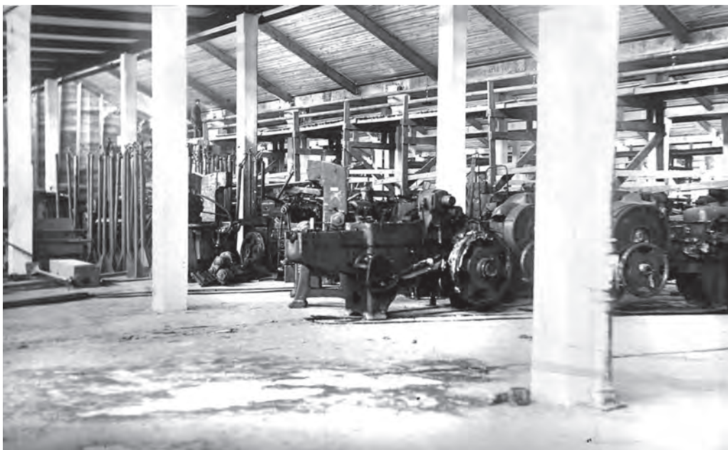
Строительство Барнаульского станкостроительного завода. 1941 г. ГААК. Ф.Р-1453. Оп. 1. Д. 18. Л. 16.
