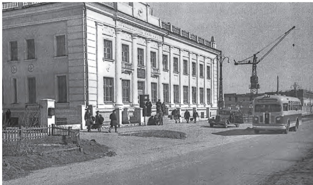
Строительство пр-та им. Ленина. 1952–1953 гг. г. Барнаул ГААК. Фотодокументы. Оп. 2. Д. 0-1939.
