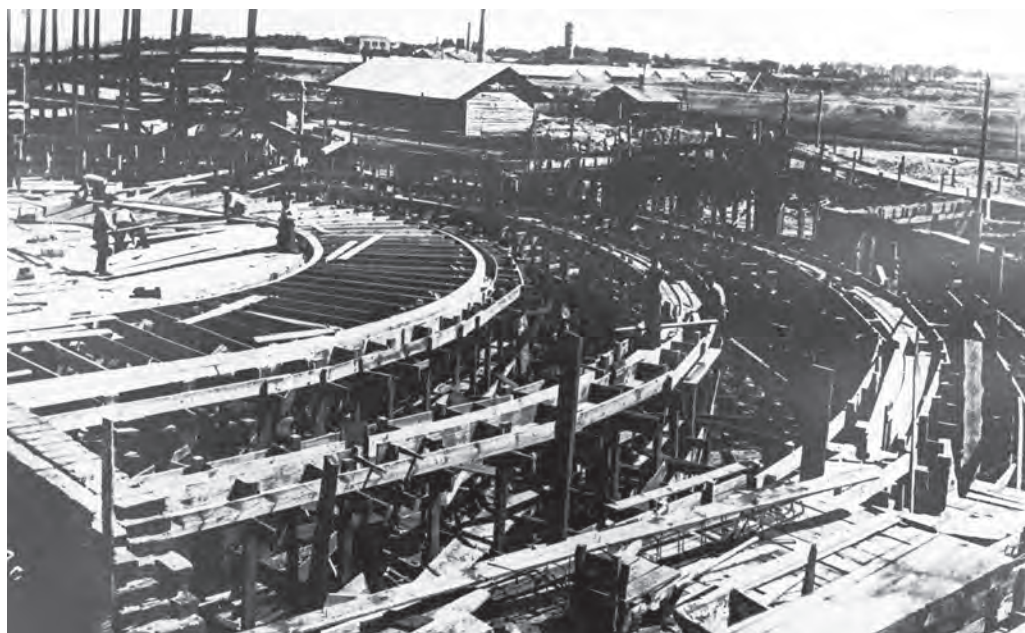
Строительство главного корпуса, столовой Барнаульского меланжевого комбината. 1933 г. ГААК. Фотодокументы. Оп. 1. Д. 6633.
