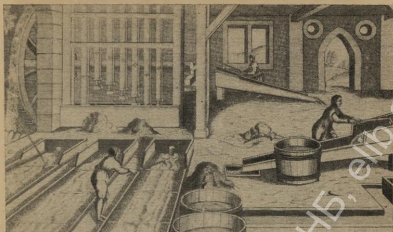
Рудообогатительное заведение с оборудованием, характерным для мануфактурной техники XVIII в. На заднем плане слева — вододействующая толчея для руды, спереди и справа — процесс промывки руды вручную
