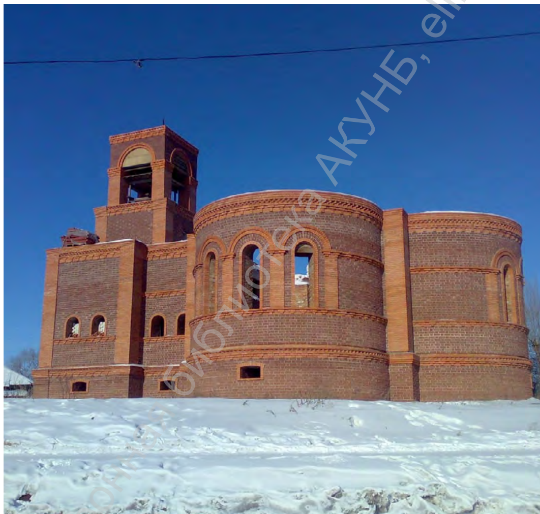
Завершение кладки перед кровельными работами (архитектор и дизайнер Елена Назарова). Введенская церковь с. Павловск. Зима 2012 г.
