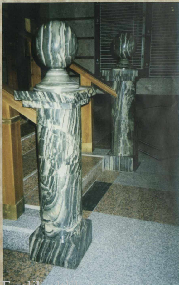
Лестничные колонны. Яшма ревневская. Изготовили мастера завода. Алтайское отделение Сбербанка РФ
